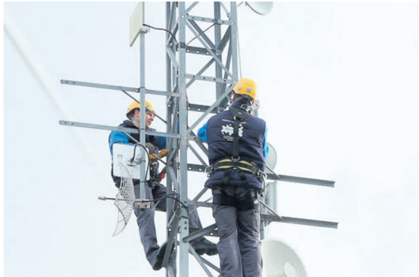
Técnicos de Intermax, que cubre parte del sur lucense, instalando un micro repetidor en una torreta.
